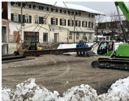
Anlieferung der Spunddielen, die gesetzt und nach Erstellung der Baugrubenumfassung wieder entfernt werden
