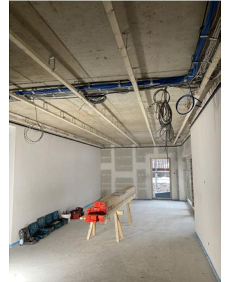
Trockenbauwände wurden bereits eingebaut und verspachtelt
