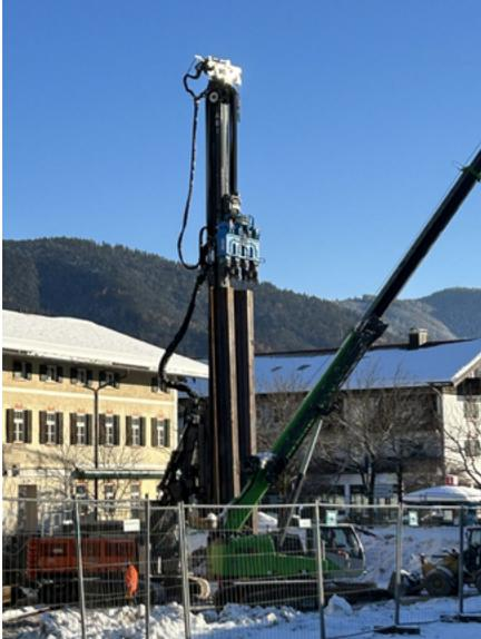
Spezielles Gerät gewährleistet das Reindrücken der Spunddielen im erschütterungsfreien Verfahren, um die umliegende Bebauung vor Vibration zu schützen.
